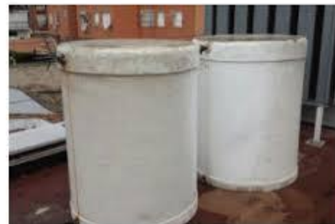
Depósitos de agua de fibrocemento
