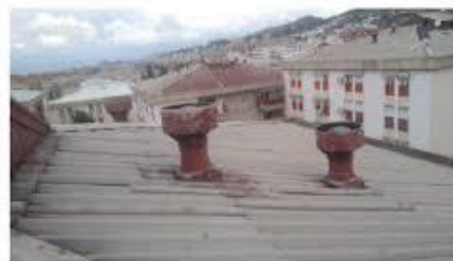
Chimeneas de fibrocemento
